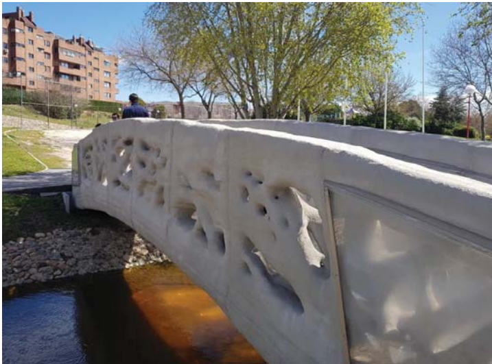
Figura 52: El primer puente peatonal impreso en 3D. (Foto: © Germán Martín)
